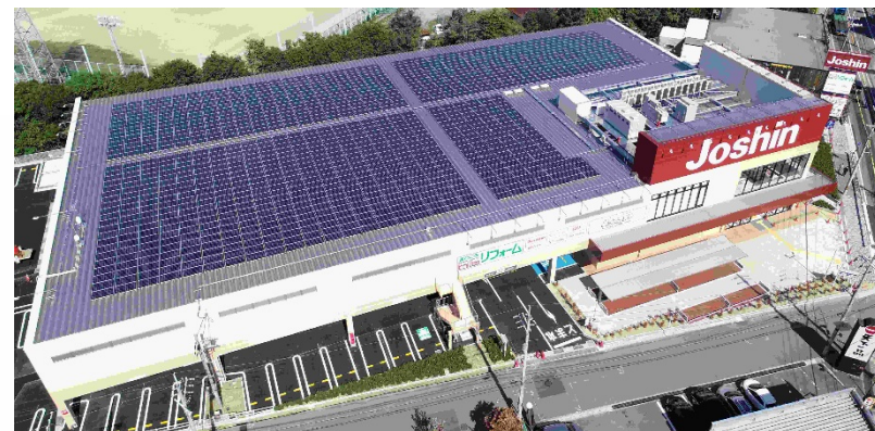
Solar panels (Rokujizo store)
