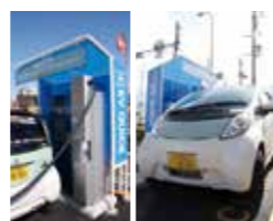
電気自動車急速充電システム
