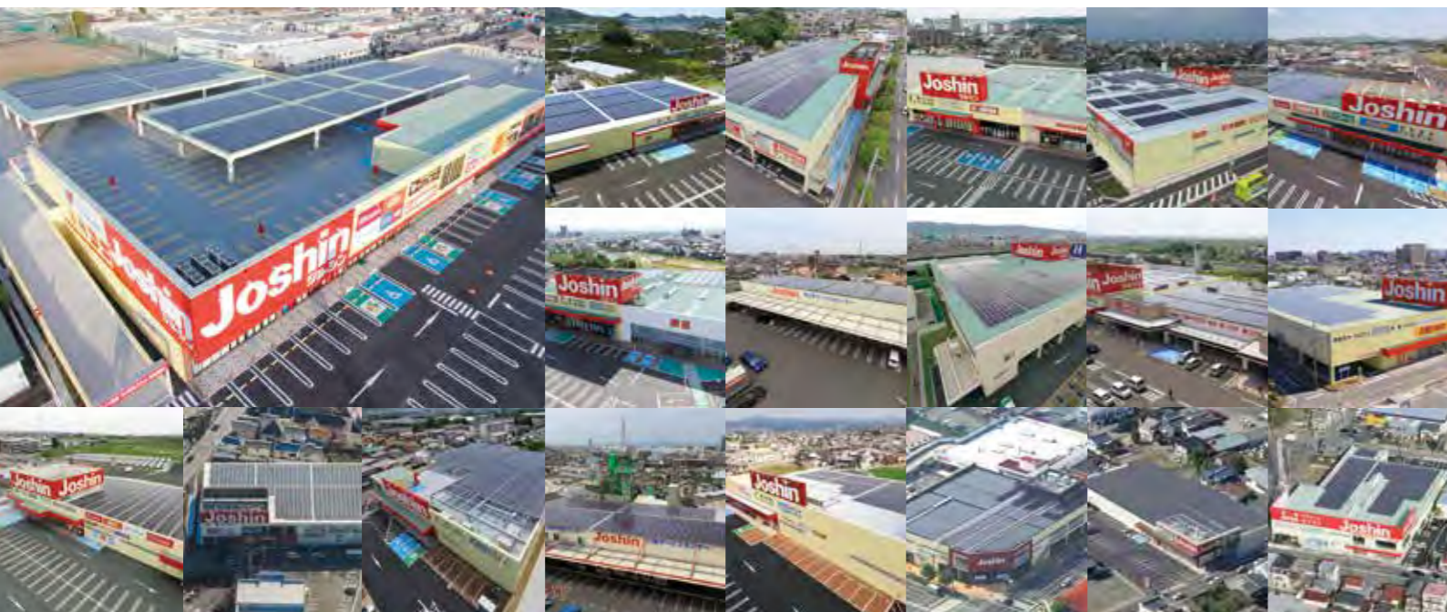
全量買取を目的とした太陽光発電システム設置店舗と事業所(外環柏原店、有田川店、東生駒店、半田店、新京城店、南大阪サービスセンター、東大阪店、姫路東店、八尾サービスセンター、斑鳩店、福崎店、小牧店、松阪店、市川大野店、瑞穂店(自店舗及びテナント棟)、伏見店、太子店、一宮尾西店)
