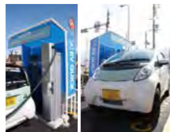
電気自動車急速充電システム
