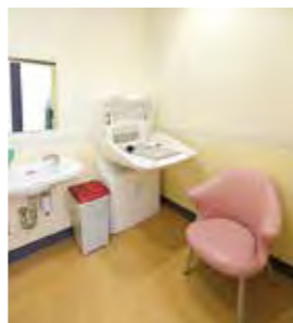
授乳室内の設備
