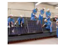
太陽光パネル設置研修
