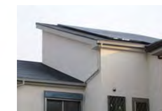
当社の太陽光発電施工例
