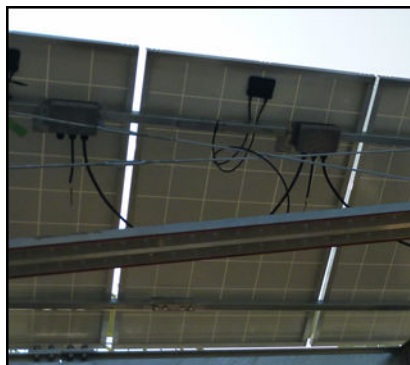
パネルの裏に「分散型 MPPT デバイス」を取付けます。
